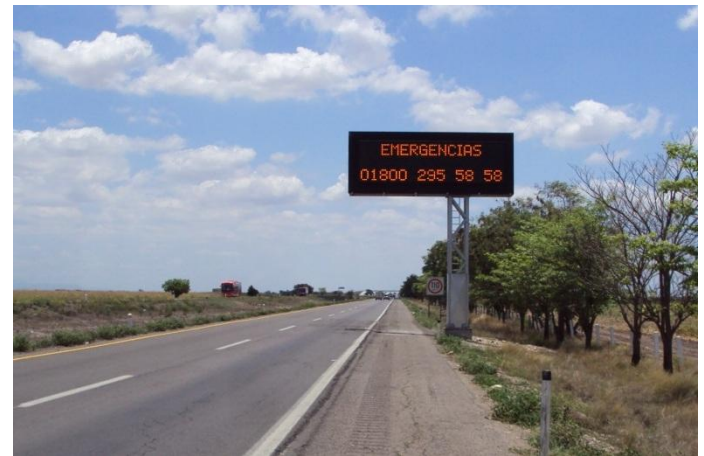
Panel de señalización variable
